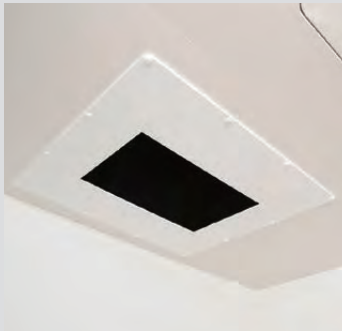
プレート取付時
