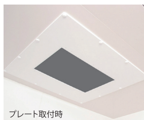
プレート取付時
